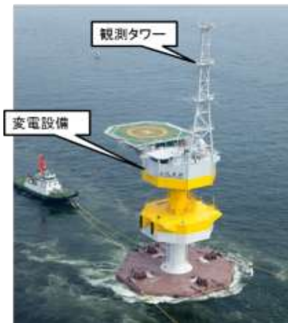
浮体式洋上風力変電設備
