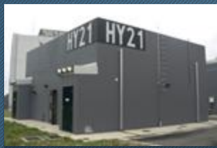
曝露棟 (HY21棟)
