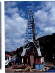
南伊豆地域で実施した坑井掘削
