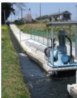
城原井路発電所(竹田市)
