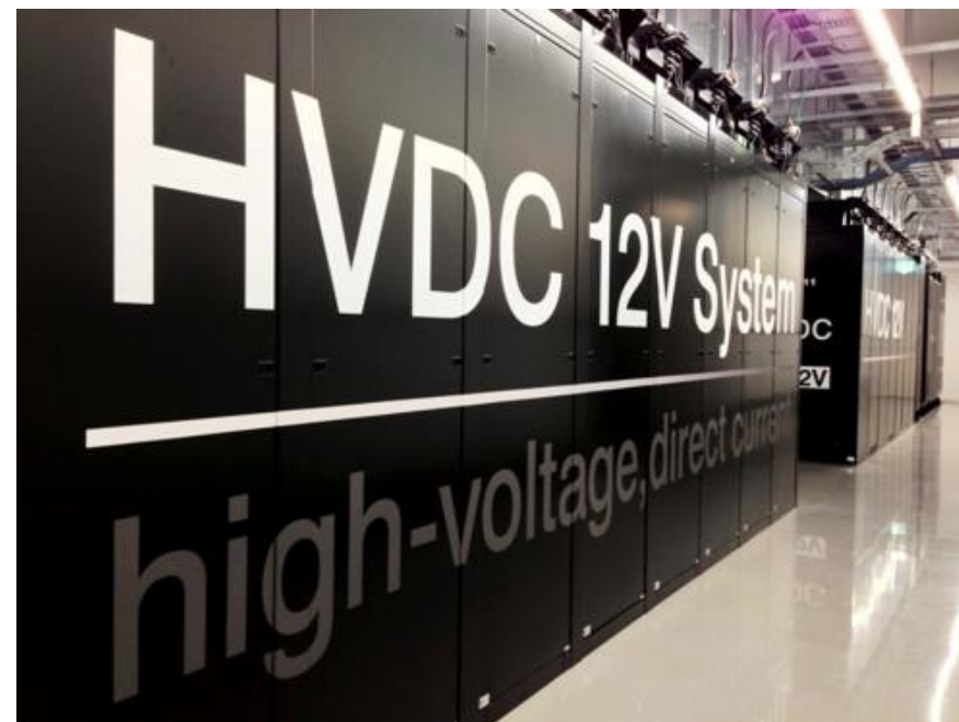
▲HVDC DC12Vシステムのサーバラック
