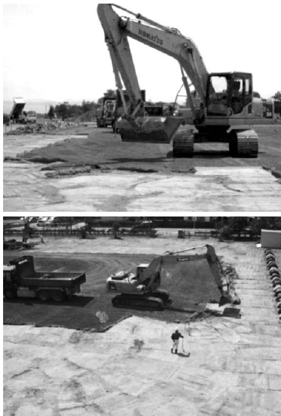
図1 重機による芝生の剥ぎ取り
